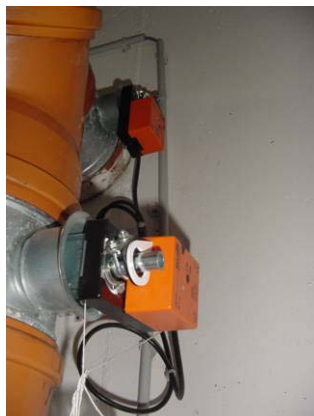
Abbildung 3.67 a-b: Umschaltklappen zwischen Direktansaugung und über EWT (Ausführung in KG-Rohr)
