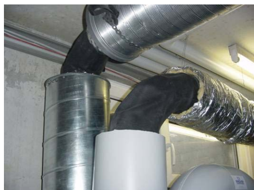
Abbildung 3.108: Provisorische Schallentkopplung durch LKW-Schläuche
