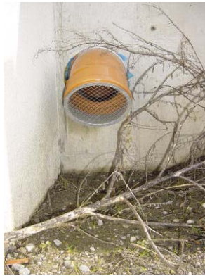
Abbildung 3.58, Abbildung 3.59, Abbildung 3.60 Einfache Ansauggitter ohne Filterung bieten keinen ausreichenden Verschmutzungsschutz für den EWT. Schneefreiheit ist beim 4. bzw. 5. Beispiel ebenfalls nicht gewährleistet
