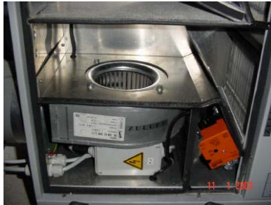
Abbildung 8.10 a-c: Automatische Bypassklappe: geschlossen – halbgeöffnet – offen
