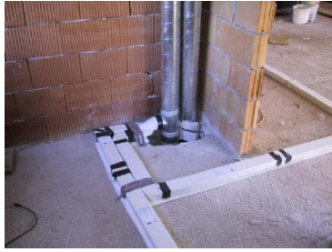
Abbildung 3.123 a-b: Positive und negative Verrohrungsbeispiele - Flachkanäle
