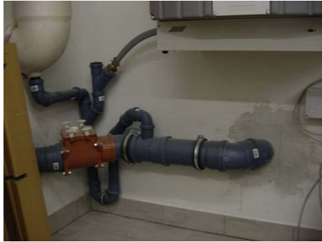
Abbildung 3.110: Kondensatabfluss für EWT und Lüftungsgerät
