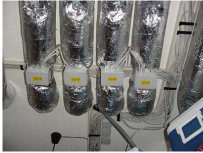
Abbildung 3.32: Stromnachheizung bei einer Anlage mit Wärmepumpe als alleiniges Heizungssystem
