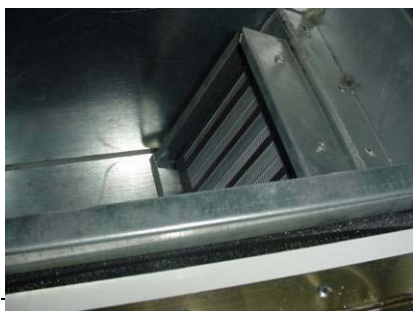
Abbildung 3.35: Elektrisches Vorwärmregister in der Frischlufteinheit als Vereisungsschutz und zur Gewährleistung der Zulufttemperatur bei einer Anlage ohne EWT (über 100 Pa Druckverlust).
