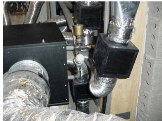
Abbildung 3.30: Nachheizregister in der Verteilerbox bei einer Anlage ohne EWT
