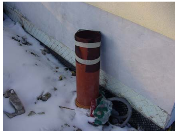
Abbildung 8.16: Gefrorenes Kondensat an der Außenwand bei der Abluft (Außentemperaturen von -8 bis -15°C und leichtem Wind). Neg: Einfaches Abluftgitter mit normalem Rohrquerschnitt (Durchmesser 160 mm). Dadurch relativ hoher Druckverlust.
