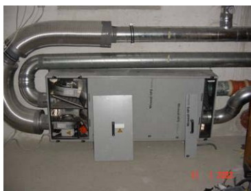
Abbildung 2.23: Lüftungsgerät mit Gegenstrom Wärmetauscher (Fa. Rewa)
