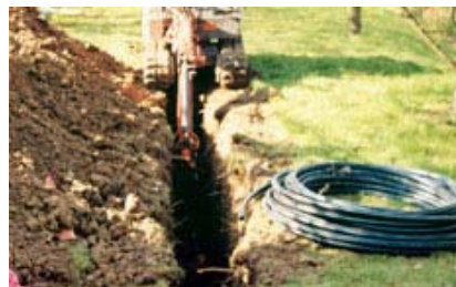
Abbildung 2.54: Verlegung Sole-EWT (NEI-Detmold)
