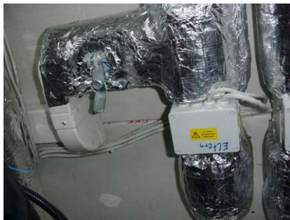
Abbildung 3.34: Stromnachheizung und Einbindung kalter Zuluft für das Elternschlafzimmer
