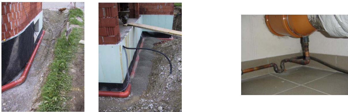
Abbildung 3.72 a-c: Erdwärmetauscherdetails
