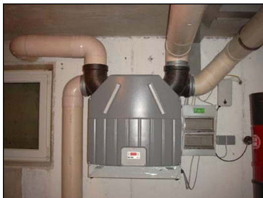
Abbildung 1.1: Lüftungsgerät mit PE-Verrohrung (Kondensatablauf fehlt)
