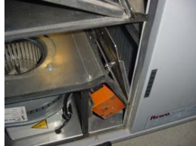
Abbildung 8.10 a-c: Automatische Bypassklappe: geschlossen – halbgeöffnet – offen
