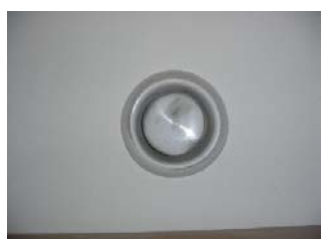
Abbildung 3.131 a-b: Deutlich verschmutzte Abluftventile
