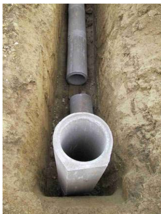
Abbildung 3.73: Sehr selten eingesetzt - Erdwärmetauscher aus Betonrohren
