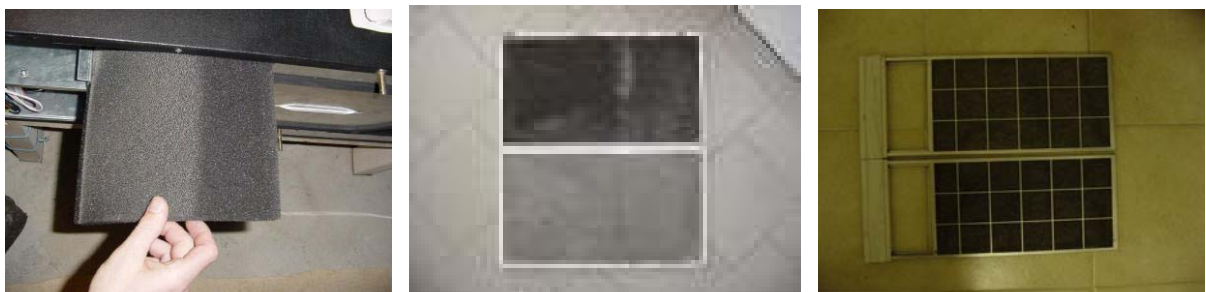
Abbildung 3.102 a-c: Verschmutzte Filtermatten
