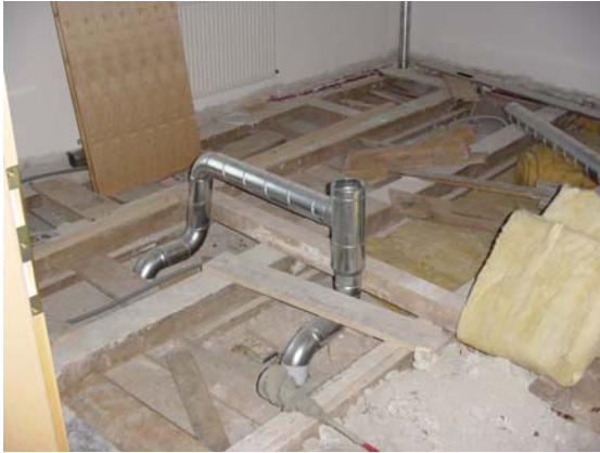
Abbildung 8.24: Abluffführung der Küche ( 2 \times 35 \text{ m}^3/\text{h} ) durch spätere Wand des Schrankraumes
