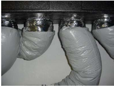
Abbildung 3.45 a-c: Schlauch-Schalldämpfer
