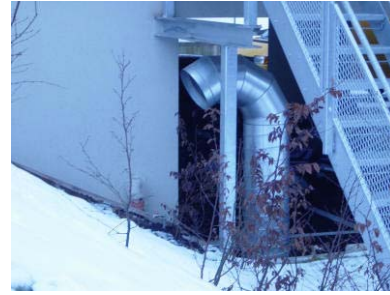
Abbildung 3.58, Abbildung 3.59, Abbildung 3.60 Einfache Ansauggitter ohne Filterung bieten keinen ausreichenden Verschmutzungsschutz für den EWT. Schneefreiheit ist beim 4. bzw. 5. Beispiel ebenfalls nicht gewährleistet
