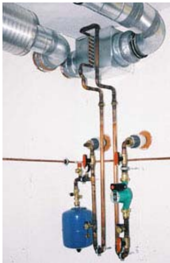
Abbildung 2.54: Verlegung Sole-EWT (NEI-Detmold)
