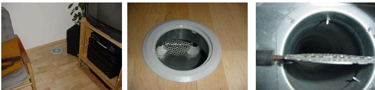
Abbildung 3.135 a-c: Bodenauslass mit Luftmengenregulierung
