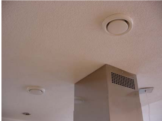
Abbildung 8.18: Die beiden Abluftventile und die Umluftschlitze bei der Dunstabzugshaube
