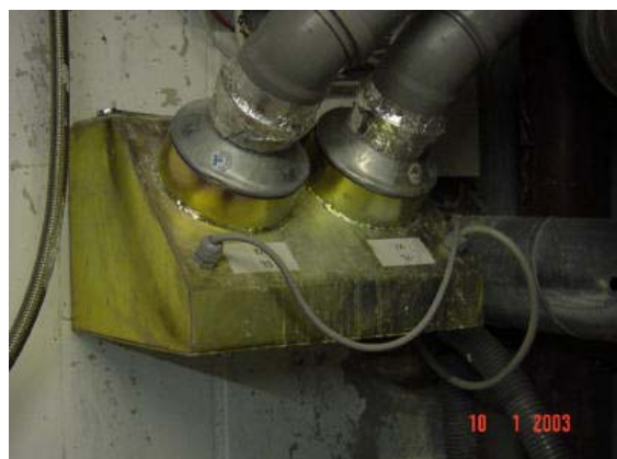
Abbildung 3.41: Vorbildliche elektronisch geregelte Verbrennungsluft für den Kachelofen aus dem Heizungskeller
