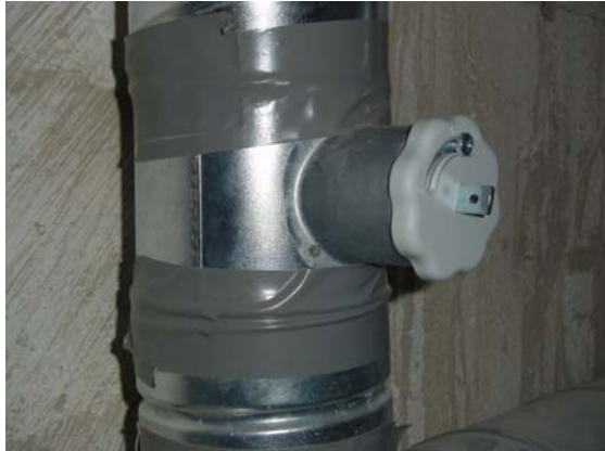
Abbildung 8.13: Drosselklappe für Luftmengenregulierung (Quellluftauslass ohne Regelmöglichkeit)
