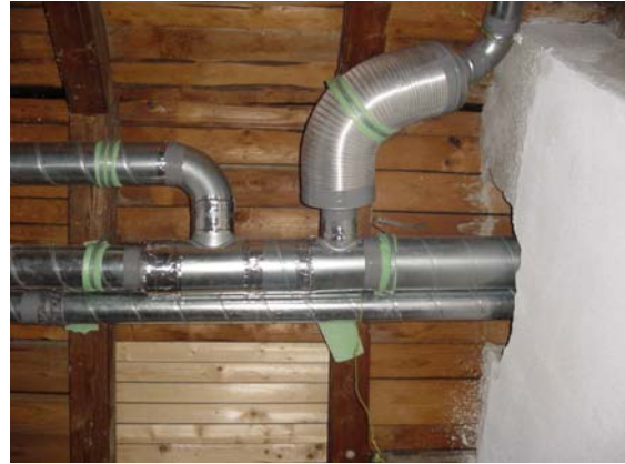
Abbildung 8.24: Abluffführung der Küche ( 2 \times 35 \text{ m}^3/\text{h} ) durch spätere Wand des Schrankraumes
