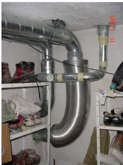
Abbildung 8.7: Abluftschalldämpfer:
