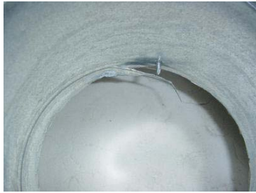
Abbildung 3.124: Abstehendes Blechteil bei einem Lüftungsrohr
