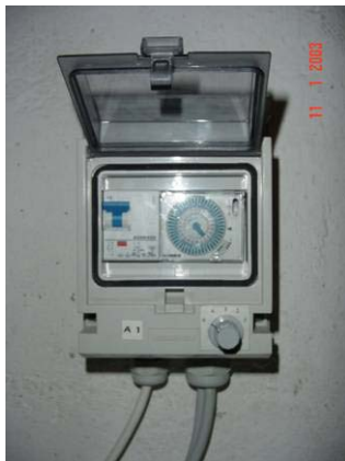
Abbildung 8.15: Steuereinheit im Keller mit eigenem Hauptschalter drei Stufen und Zeitschaltung. (Gerät gibt es auch mit BUS-gesteuerter Regelung und Filterwechselanzeige).
