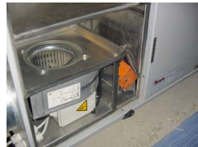
Abbildung 8.10 a-c: Automatische Bypassklappe: geschlossen – halbgeöffnet – offen
