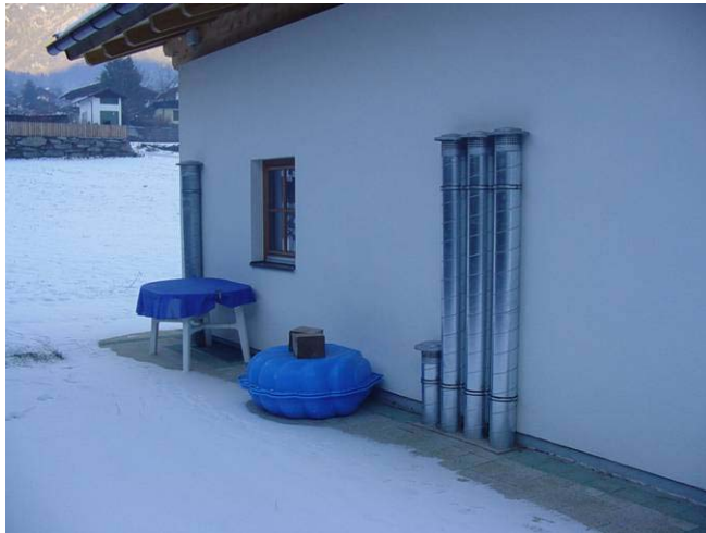
Abbildung 3.65: Beispiel für Frischluftansaugung bzw. Fortluftführung
