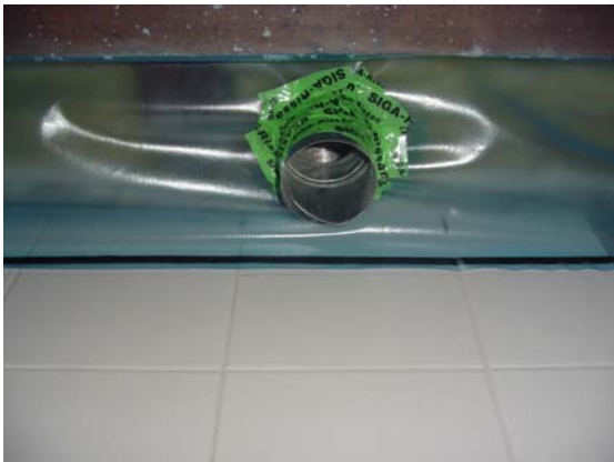
Abbildung 8.26: Abgeklebte Durchdringung der Luftdichteebene bzw. Dampfbremse im Bad
