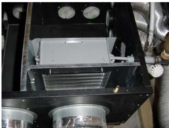
Abbildung 3.30: Nachheizregister in der Verteilerbox bei einer Anlage ohne EWT
