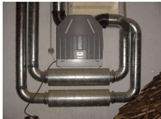
Abbildung 1.1: Lüftungsgerät mit PE-Verrohrung (Kondensatablauf fehlt)
