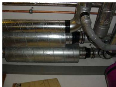
Abbildung 3.47: Starrer Schalldämpfer
