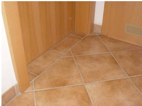
Abbildung 3.127: Schleiftür mit zu geringem Abstand (Kinderzimmer) und Tür mit Überström gitter (Abstellraum)
