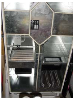
Abbildung 3.82: Lüftungsgerät mit Wechselstrommotoren
