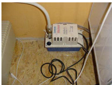
Abbildung 3.112: Nachgerüstete Kondensatpumpe
