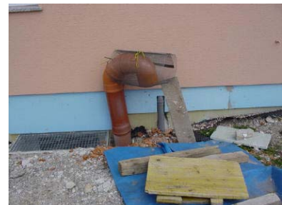
Abbildung 3.64 a-c: Provisorien die teilweise über mehrere Jahre verwendet werden
