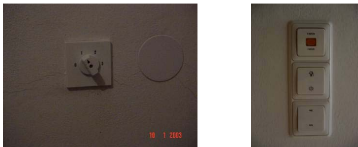
Abbildung 3.90 a-b: Einfache Schalter für die verschiedenen Lüftungsstufen (3 bzw. 2 Stufen)
