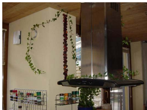
Abbildung 3.37: Umlufthaube und Abluftventil im Küchenbereich
